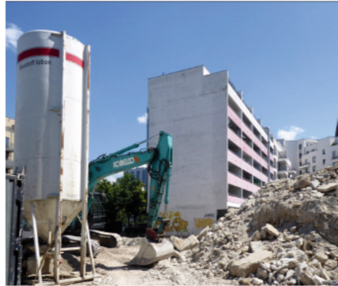
Bauvorbereitungen an der Kurfürsten-/Ecke Kielganstraße im Mai 2024
