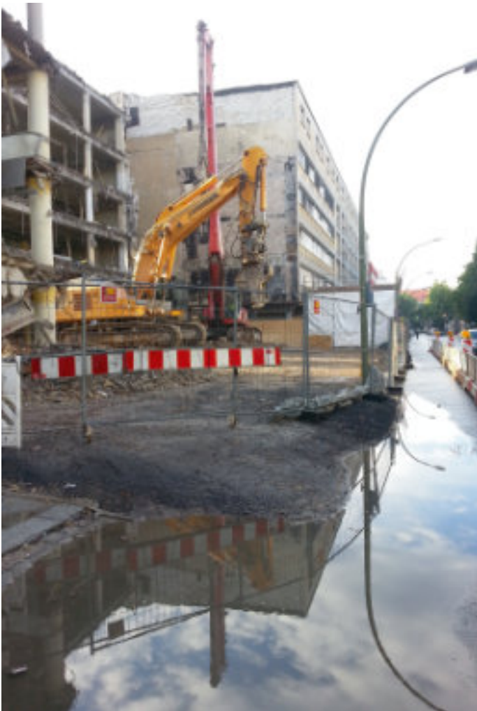
Abriss von Haus Nr. 32-34 (vormals "DÄNISCHES BETTENLAGER") in der Genthiner Straße im Juli 2017, dahinter das „Pro Seniore Krankenhaus“
