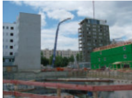
Die Baustelle John Jahr-Haus an der Ecke Kurfürstenstraße/Schillstraße im Juni 2023
