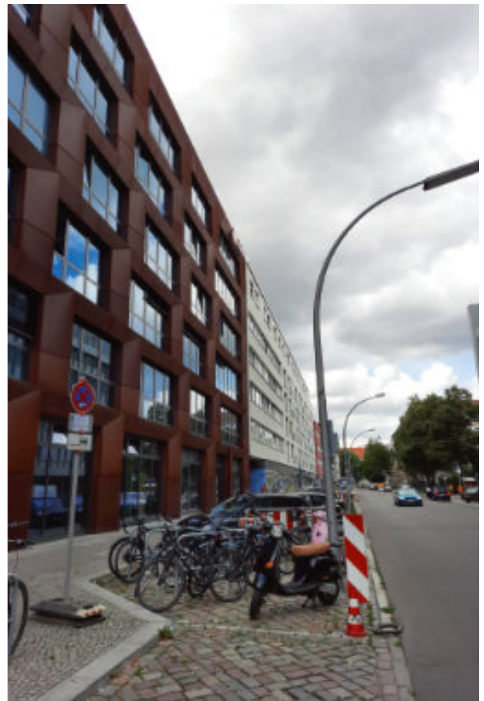
An dieser Stelle steht heute das neue Bürohaus mit „Rost-Appeal“-Fassade
