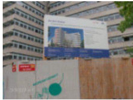
Bauschild am BIM-Objekt im Rückbau
